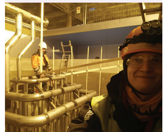
図4 Polar Night Energy の蓄熱槽のダクトを検査する Eronen 氏 (手前) と Ylönen 氏。
